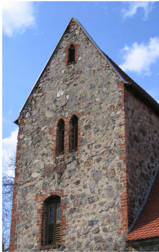
▲ Turm der Wehrkirche
